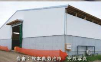
畜舎：熊本県菊池市 完成写真
