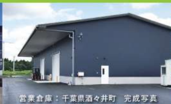
営業倉庫：千葉県酒々井町 完成写真
