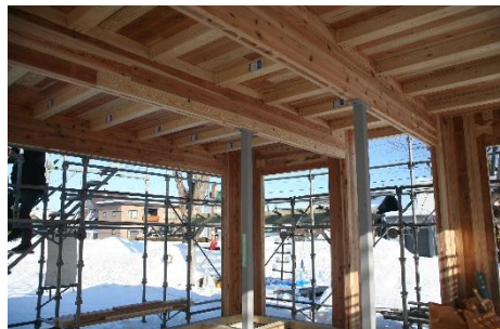
CLT のユニットを設置し接合した構造
