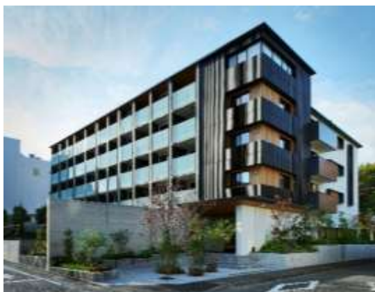
2021 年の第 1 号物件「MOCXION INAGI」 (1 階：RC 造、2～5 階：木造)
