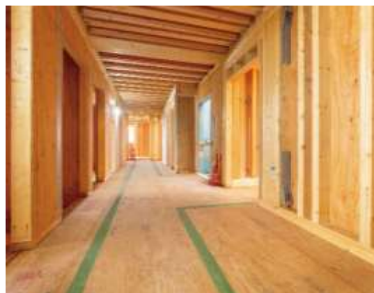
2021 年の第 1 号物件「MOCXION INAGI」 (1 階：RC 造、2～5 階：木造)
