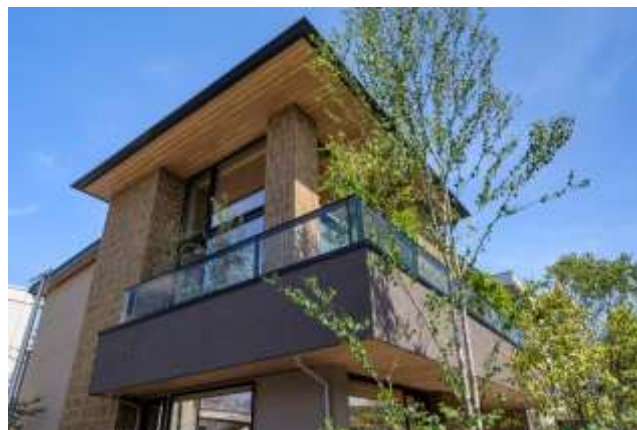
2方向持ち出しバルコニー
