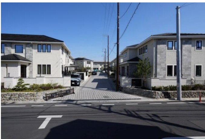
(完成後) エントランス周辺外観
