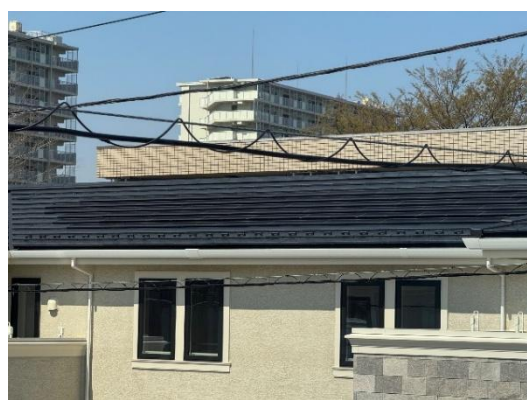
「東京ゼロエミ住宅」の基準への適合に必要な太陽光パネルの設置
