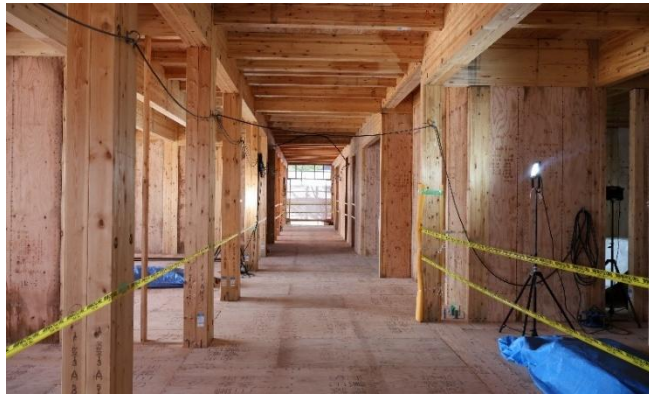
SE 構法による強固な構造体（施工時写真）
