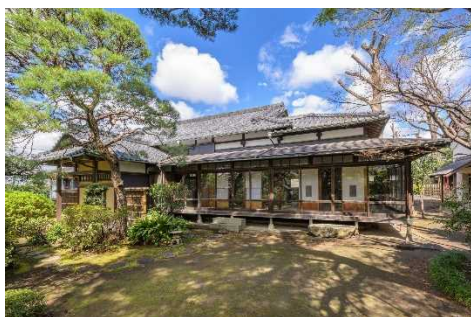
耐震改修工事前
