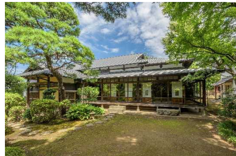
耐震改修工事後
