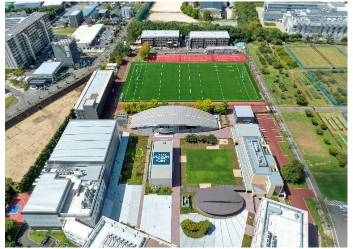
RSJ全体配置（写真中央が食堂棟）
