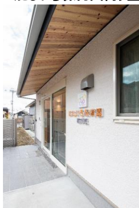
エントランス (軒裏 CLT 現し)
