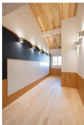
ホール (天井 CLT 現し)
