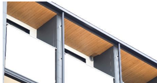
国産材（北海道産トドマツ）を使用した軒裏仕上げ
