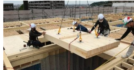
施工中写真③（国産材（信州産カラマツ）を使用した 5 階床根太となる NLT 施工の様子）
