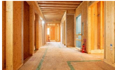
施工中写真②
