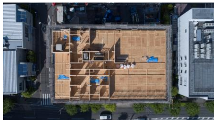
施工中写真①
