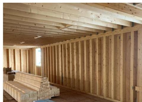
施工中の現場写真（2×6耐力壁）
