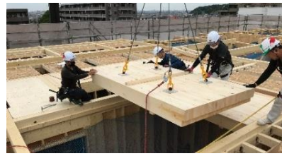
NLT 施工の様子
