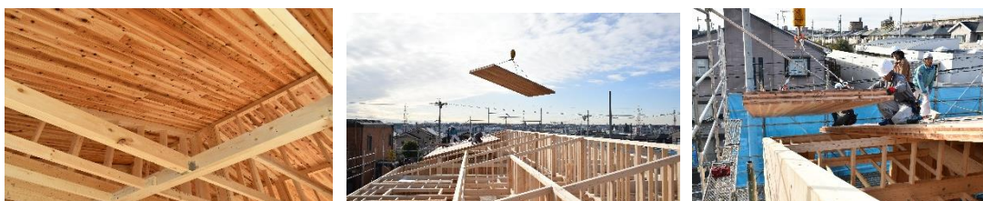
施行中現場写真
