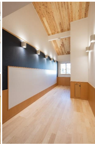
ホール（天井CLT現し）
