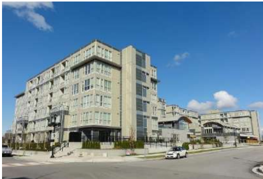
建設地：カナダ プリティッシュ・コロンビア州 2012年 用途：6階建集合住宅（木造） 延床面積：約18,215㎡ パネル施工
