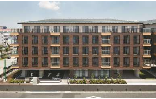
建設地：東京都 2016年 用途：5階建特別養護老人ホーム（1階RC造/2～5階木造） 延床面積：9,773㎡
