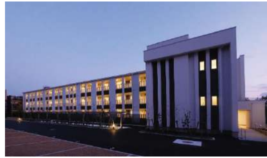
建設地：兵庫県 2019年 用途：3階建社宅（木造） 延床面積：2,017㎡
