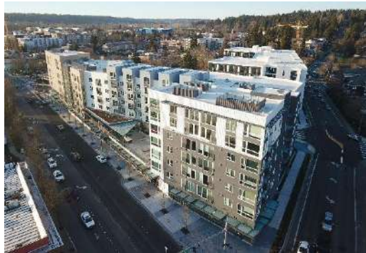
建築地：アメリカ ワシントン州 2018年 用途：7階建集合住宅（1階RC造/2～7階木造） 延床面積：約15,900㎡ パネル供給
