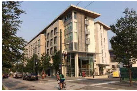
建築地：カナダ プリティッシュ・コロンビア州 2017年 用途：6階建集合住宅（木造） 延床面積：約7,317㎡ パネル施工
