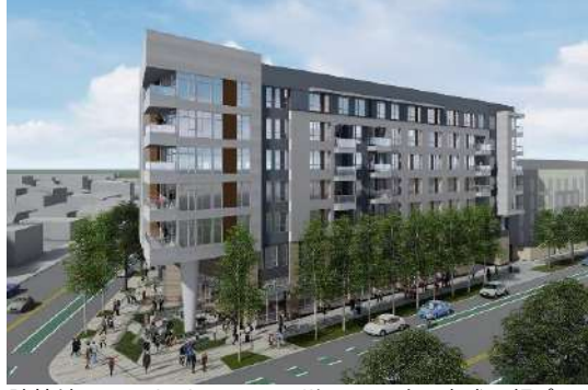
建築地：アメリカ カリフォルニア州 2020年 完成予想パース 用途：7階建集合住宅（1～2階RC造/3～7階木造） 延床面積：約21,925㎡ パネル供給
