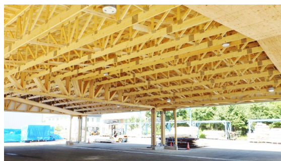
スマート倉庫内観
