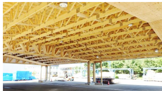
スマート倉庫内観
