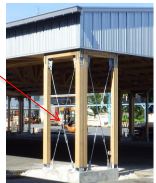
ターンバックルブレース
