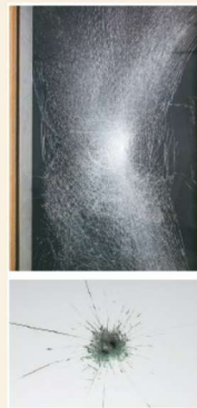
<防犯ガラス破損体験>
