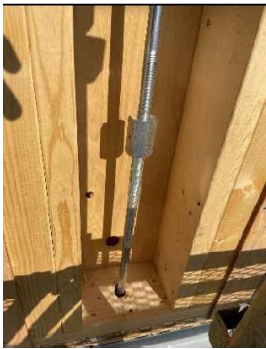
ロッドマン 上棟時
