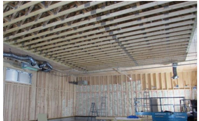
上棟時 店舗内部
