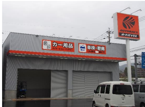
タイヤ売場外観 ロッドマンを開口の中柱に使用
