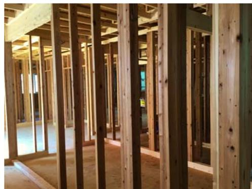
構造材に国産材を使用した個人住宅の上棟写真
