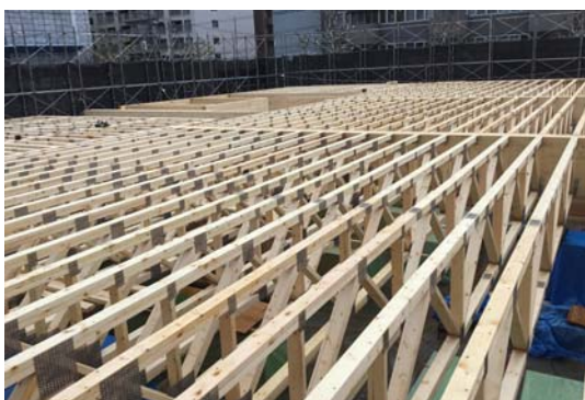
施工中2階床平行弦トラス
