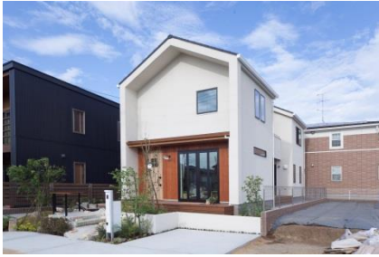
モデル棟 (A 棟) 外観
