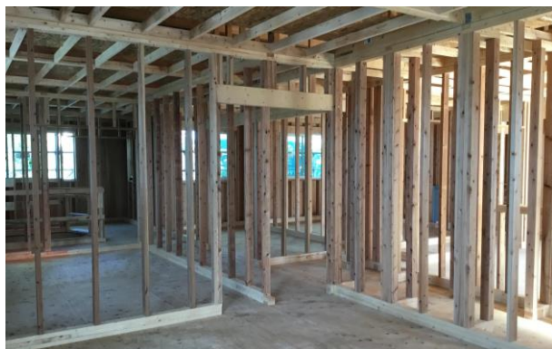
地元九州産材使用の上棟現場写真
