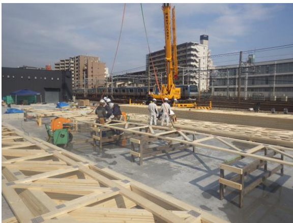
コネクトラスの現場接合作業
