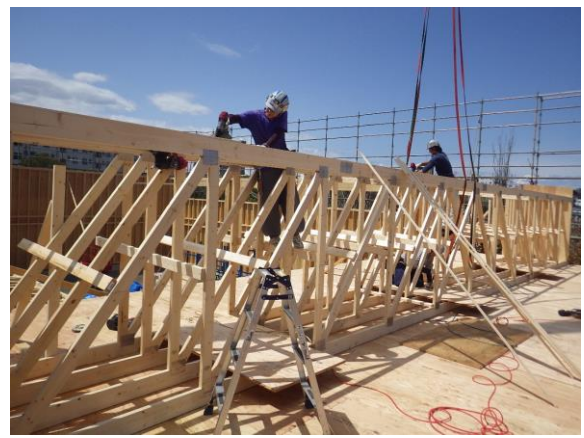
コネクトラスユニット作成の接合作業
