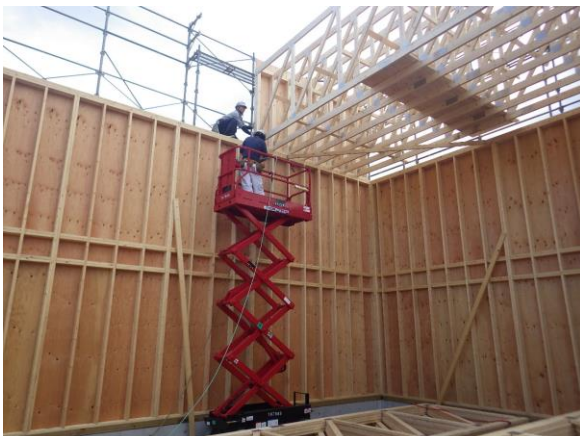
コネクトラスユニットの設置作業
