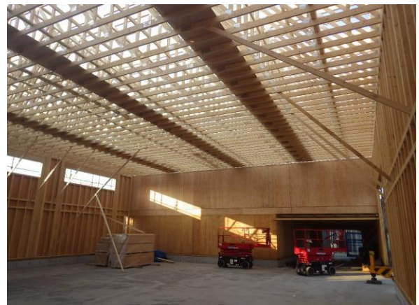
設置されたコネクトラスユニット
