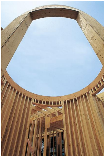
ラウンドウォール工法 構造躯体 参考写真
