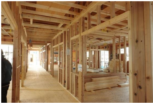
鹿児島県産材を使用した上棟現場
