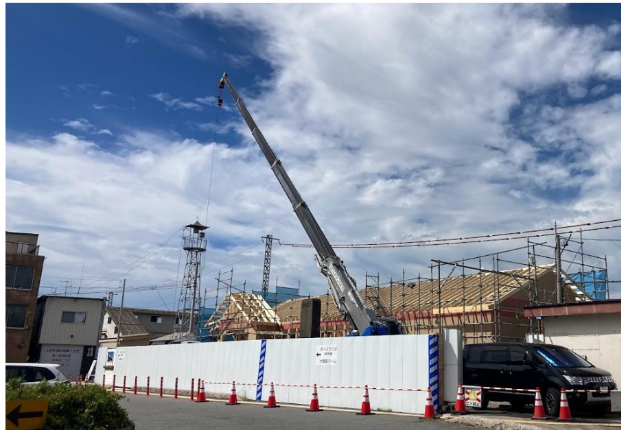
駅舎・郵便局建築中の全体写真
