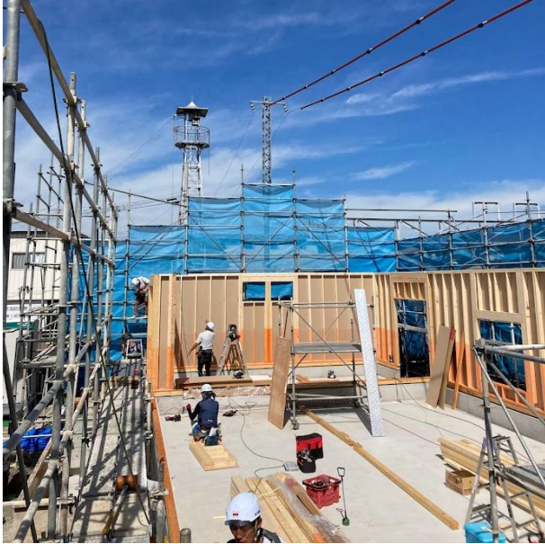
駅舎・郵便局の床組みをせず、壁を建てていく工程
